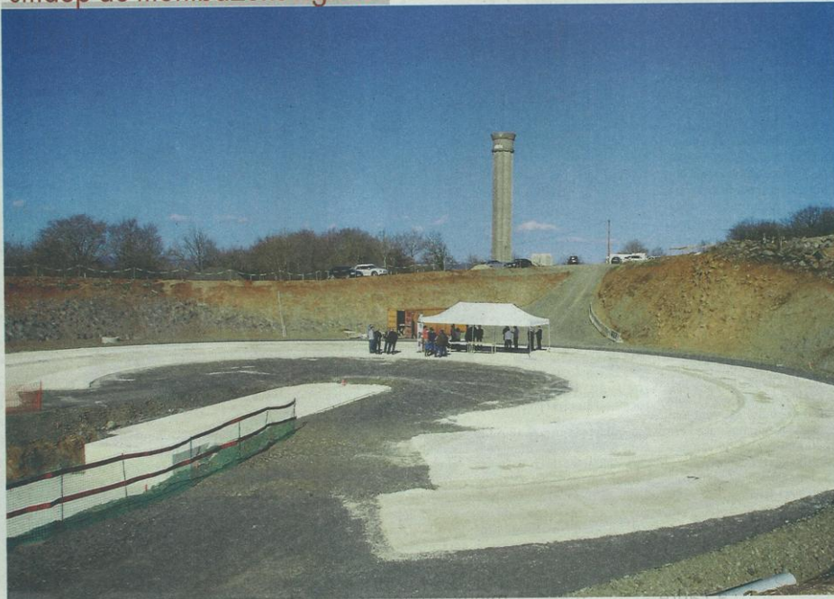
Au pied de la cheminée d'équilibre de Roquelaure, l'assise du futur réservoir est terminée. / Photo DDM, J.-L. P.
