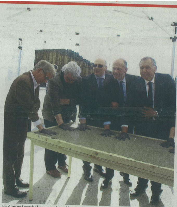
Les élus ont symboliquement posé la première pierre du chantier vendredi./DDM, J.-L.P.
