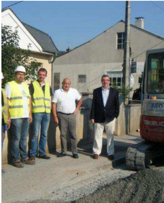
Un chantier en action pour Rignac./ Photo DDM
